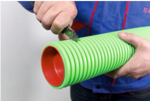
1) Укорачиваем трубки до необходимой длины.
