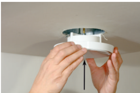
1) Пластмассовый тарельчатый клапан вдавливаем в закрепленный вывод вентиляционной системы.
