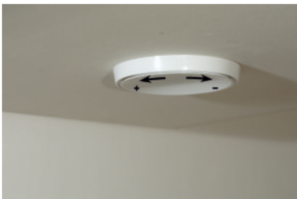
3) Регулировка протока воздуха производится вращением центрального диска, которым изменяется открытие клапана.
