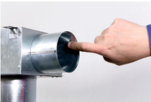
3) Внутреннюю поверхность выпуска смазываем антифрикционным препаратом*.
