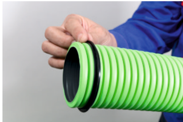
2) На 2 или 3 паза устанавливаем уплотнительное кольцо.
