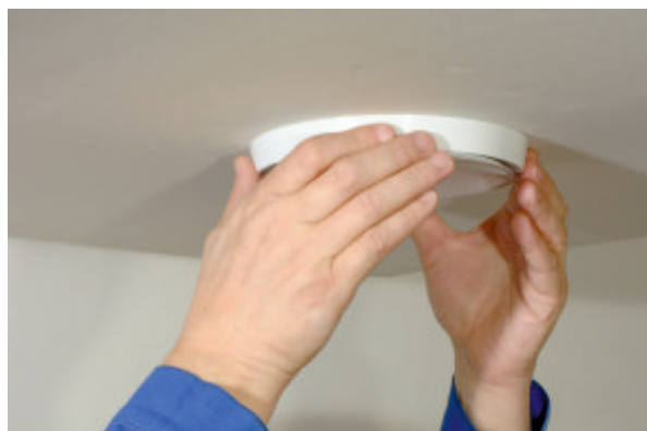
2) Клапан вдавливаем до упора к потолочной / стеновой конструкции.
